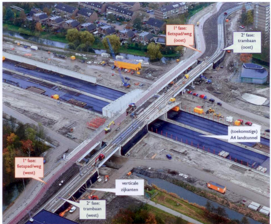
Weergave van alle bouwfases van de trambaan over de A4.
