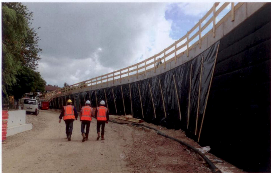
De verticale zijwand met EPS-blokken.
